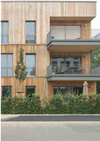
Beispiel massive Holzkonstruktion
